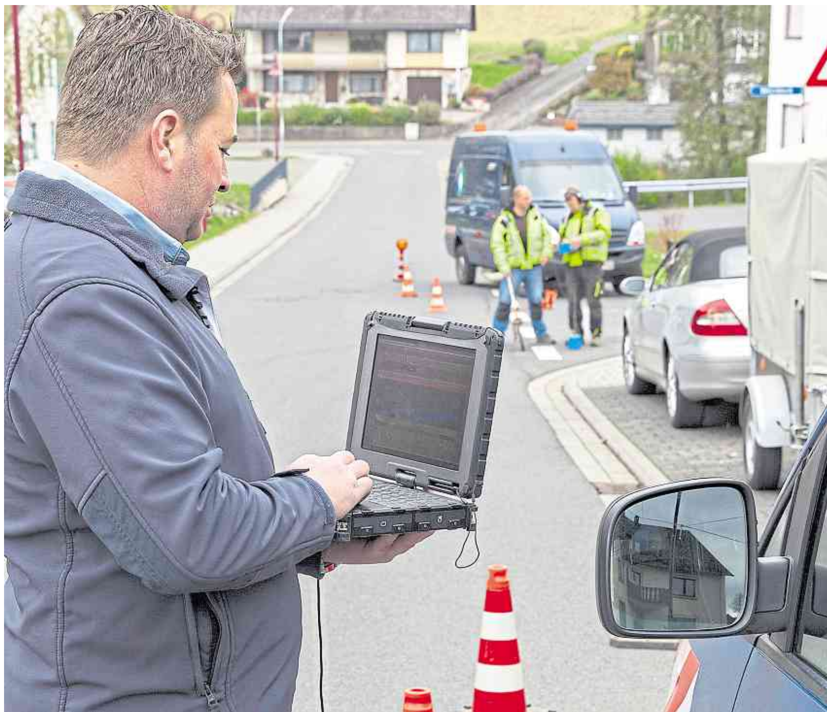
Die Mitarbeiter der Wasserversorgung können mit speziellen Messgeräten die Schadstelle immer genauer eingrenzen, bis ein Rohrbruch entdeckt ist. Mit einem sogenannten Korrelator gehen hier Joachim Staudt, Jürgen Koch und Markus Saberniak auf Rohrbruchsuche.
